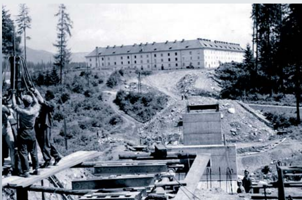
Beginn der Pilotierungsarbeiten beim Bau der Europabrücke 1957 (Foto: Archiv Stadtamt Judenburg)
